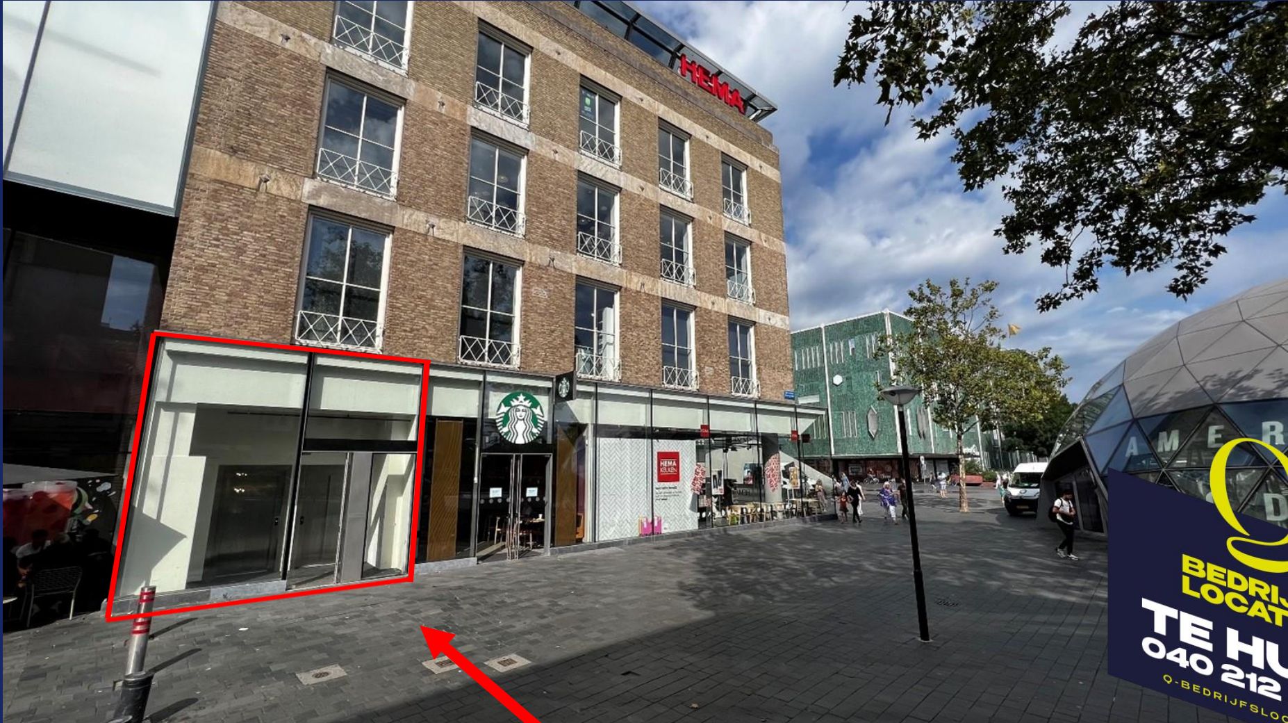
Seperate entree/lift naar kantoor
